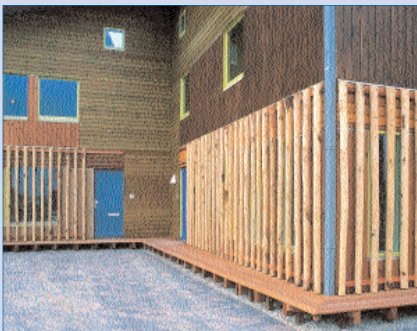
◁ 2. Voor de houtskelet-bouwwoningen van het project Oudstraat Zenderpark te IJsselstein lopen plankiers van bangkirai. Ontwerp: Jean Désert rem. Den Haag.
