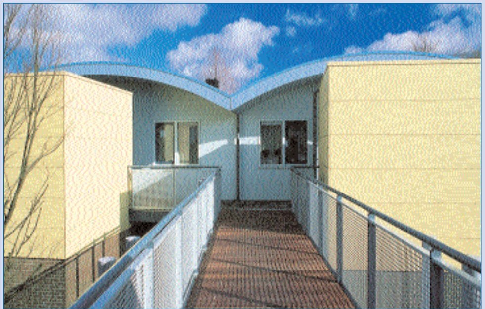
△ 3. Galerij met bangkirai dekdelen in optop-project Lisse. Ontwerp optopen: Architectenbureau ir Henri Stol Sassenheim.
