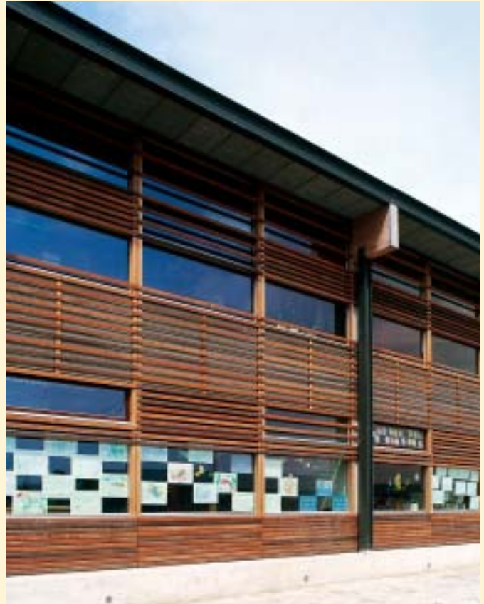
Gevelbelijning in guaruba. Brede school Papendrecht; ontwerp: Architectuurbureau Sluijmer en van Leeuwen Utrecht.
