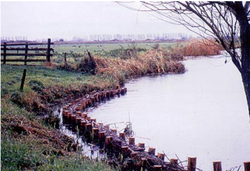
Vooroeverconstructie van kastanjehouten palen met rijshout
