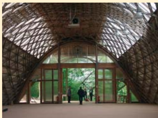
Downland Gridshell te Singleton, Engeland; ontwerp: Edward Cullinan Architects Londen. Hoogstandje in Engels eiken.
