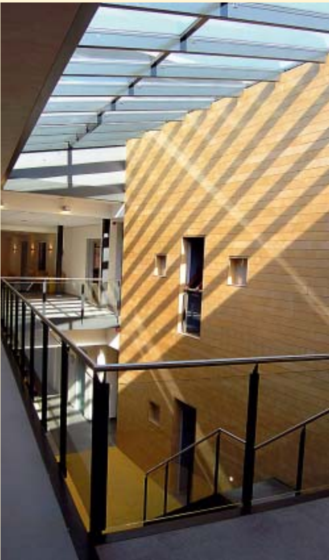
Kantoor Verkerk te Zevenaar; ontwerp (en foto): Han van der Zee Architecten Duiven. De berkentriplex geveldelen zijn voorzien van messing en groef.
