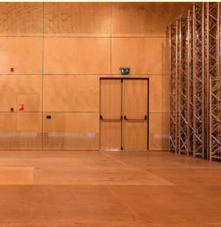
Theater Onafhankelijk Toneel Rotterdam, van binnen en buiten bekleed met berkentriplex. Ontwerp: Franz_Ziegler, bureau voor architectuur en stedenbouw Rotterdam.
