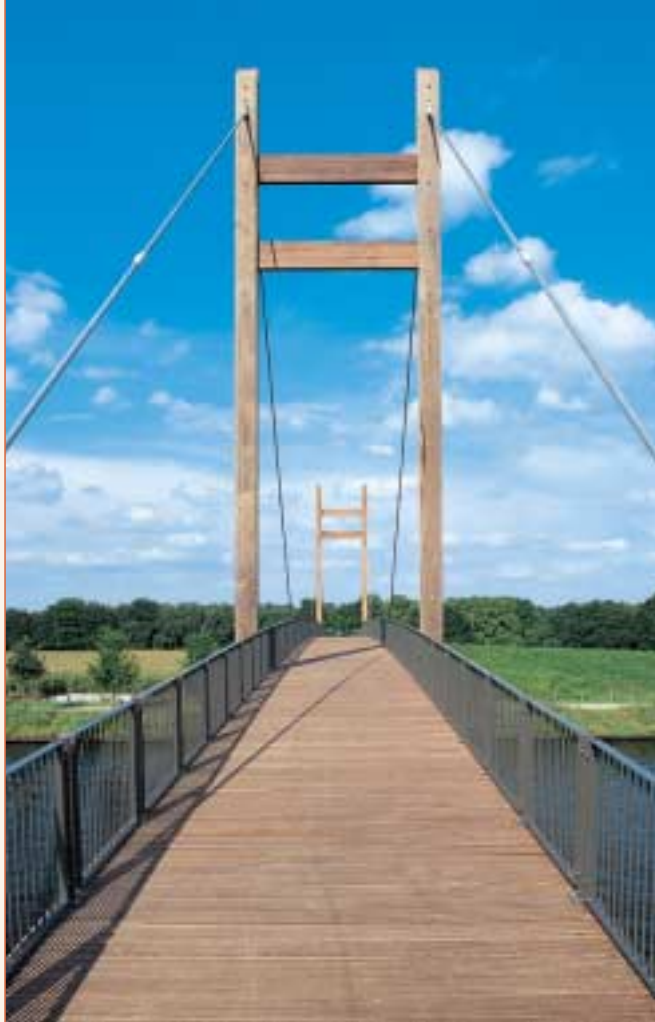
◁ 9. De tuibrug over het Twentekanaal bij Enschede is geheel uitgevoerd in azobé.
